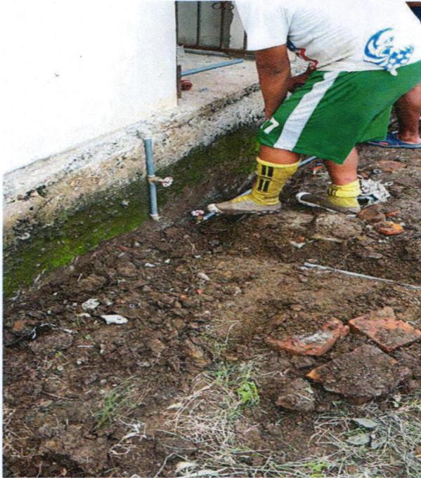
Ilustración 13. Excavación para la implementación de las tuberías
