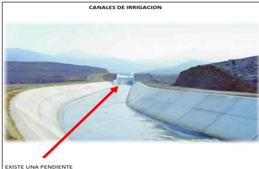
*Ilustración 27 Canales de irrigación – existen pendiente.*
