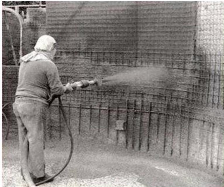
*Ilustración 12 Operario aplicando concreto lanzado.*
