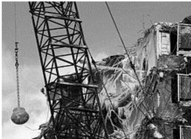
*Ilustración 10 Bola de demolición colgada de una grúa.<sup>40</sup>*
