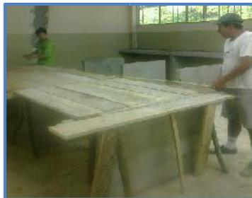
*Ilustración 21 Armado del encofrado
