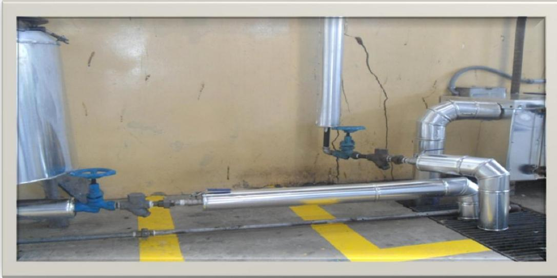
Las líneas de vapor condensado son dos, la primera línea procede de la línea de vapor de alimentación y la segunda proviene de la chaqueta de vapor. Estas líneas se encuentran recubiertas para evitar los riesgos por quemaduras con el vapor, y las mismas están conformadas por una válvula de compuerta, una trampa de vapor y una válvula de cierre rápido.
