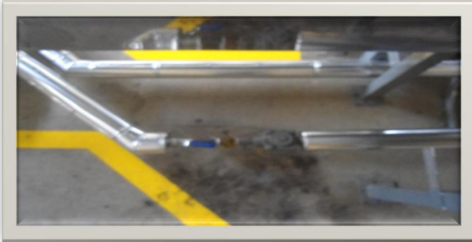
Las líneas de vapor condensado son dos, la primera línea procede de la línea de vapor de alimentación y la segunda proviene de la cámara de aire, el vapor proveniente de la cara de aire es el utilizado para calentar el aire, este vapor pasa a través de un serpentín que se ubica dentro de dicha cámara.
