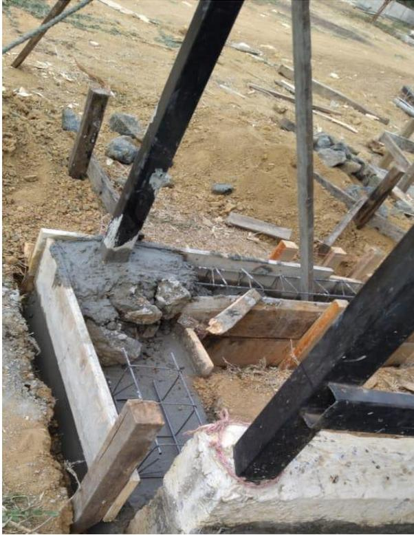
*Anexo 18: Relleno de Viga con Concreto*
