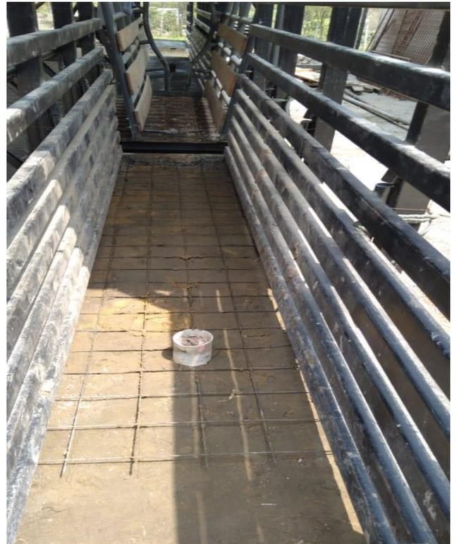
*Anexo 21: Colocación de malla en el Pisos del Embudo 2*
