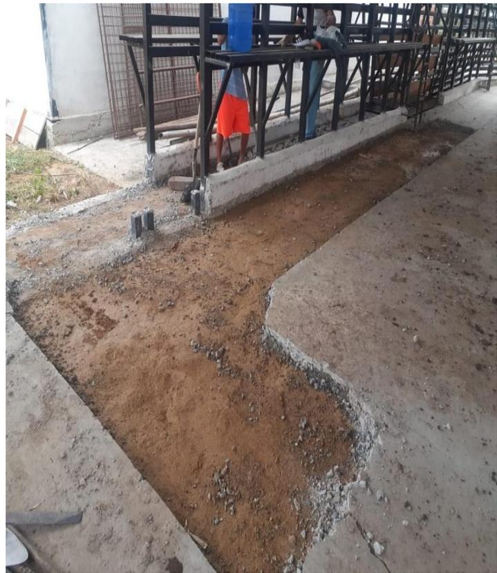
*Anexo 9: Demolición de Piso Agrietado*
