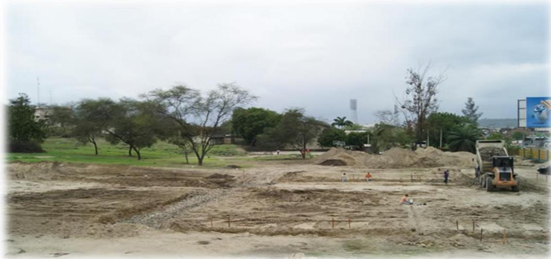
**FOTO N° 2:** Colocacion de material petreo una vez ya replanteado el terreno para el soporte de las vigas.
