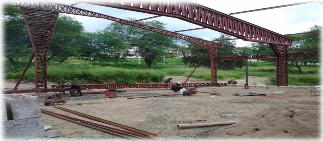
**FOTO N° 10:** Ya colocada la cercha metálica
