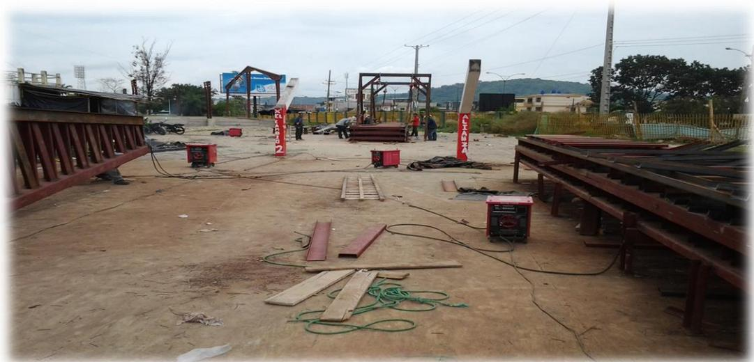
**FOTO N° 13:** Soldando la parte superior de la estructura
