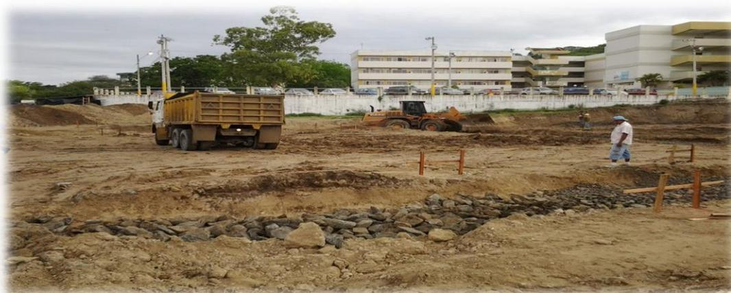
**FOTO N° 5:** Desalojo del material pobre para luego rellenar con material bueno
