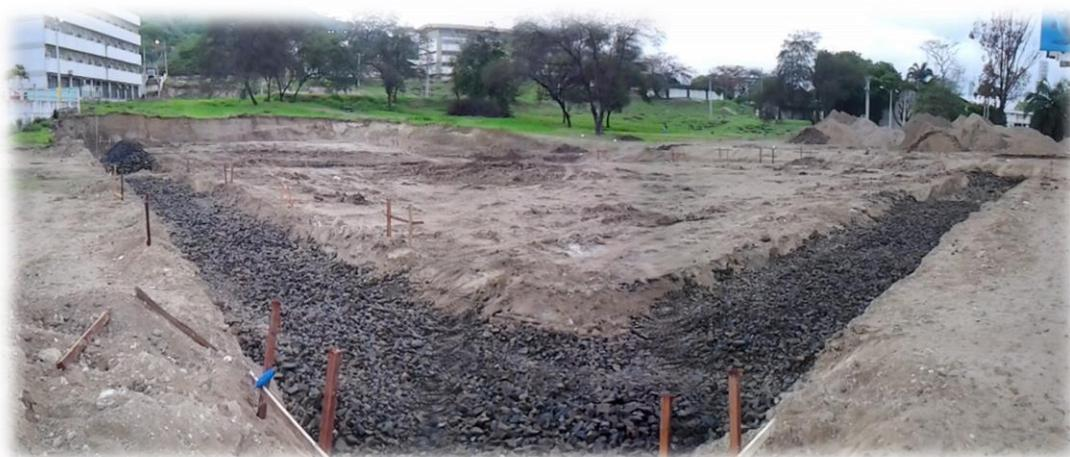
**FOTO N° 3:** Colocando material de mejoramiento en la subrasante para mejorar la capacidad portante del suelo.
