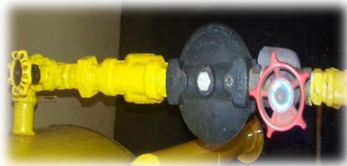
**Paso 3.-** Encender el sistema de ablandamiento para que ingrese el agua ablandada a la cámara por medio de la bomba. La bomba se apagará cuando el nivel indicado en el Mc Donald se haya alcanzado.
