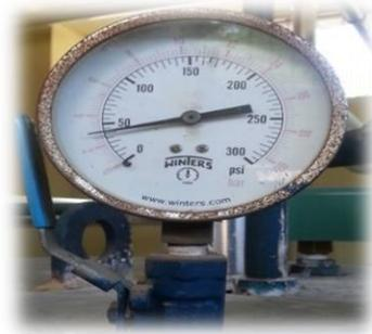
**Paso 6.-** Una vez alcanzado la presión adecuado (50 psi) la caldera se apagará automáticamente y se procede a abrir la válvula de distribución de vapor que lo conduce al acumulador y a los demás equipos del laboratorio. Se procede a purgar el condensado que existe dentro del acumulador.
