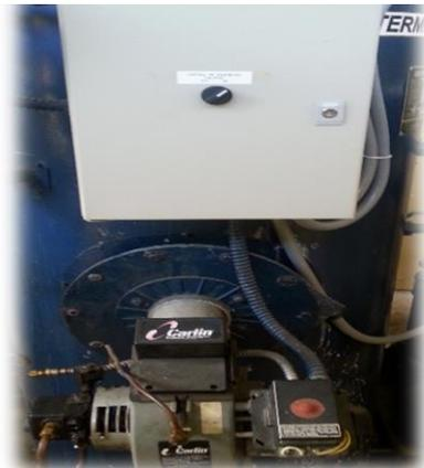
**Paso 5.-** Se observará en el manómetro que la presión interna del caldero comenzará a subir; esto debe ocurrir teniendo la precaución de que la válvula de salida de vapor se encuentre completamente cerrada.
