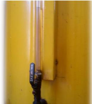
**Paso 2.-** Abrir las válvulas de paso de combustible hacia la caldera, verificando que la válvula de distribución y purga se encuentren cerradas.
