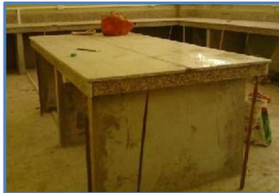
*Ilustración 19 Construcción de mesón central.
