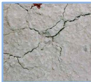
*Ilustración 6.-Apariencia típica de las fisuras por secado superficial del concreto*
