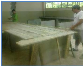
*Ilustración 21 Armado del encofrado
