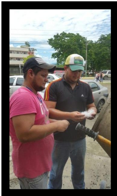
**Anexo 9.**Colocando Fibras de polipropileno y microfilamento fino
