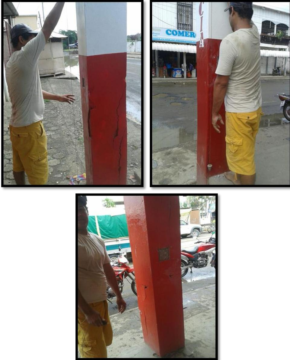
FIG.(5) PLOMADA DE LAS COLUMNAS, EN ESTADO CORRECTO
