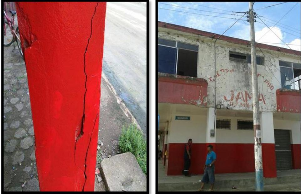
**FIG.(3)** SE MUESTRA UNA GRIETA DE GRAN LONGITUD Y MEDIANA PROFUNDIDAD, EL ESTADO DEL REVESTIMIENTO PRESENTA GRAN DETERIORO.
