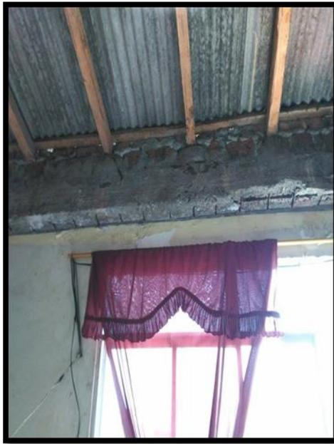
**FIG. (4) PRESENCIA DE HUMEDAD Y DESPRENDIMIENTO DEL REVESTIMIENTO**
