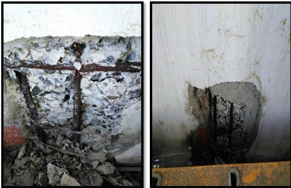
**FIG. (1) COLUMNA CARBONATADA, MUESTRA QUE LOS RESULTADOS ESCLEROMETRÍCOS PARA VALORACION DE RESITENCIA DEL HORMIGON SON IRREGULARES**
