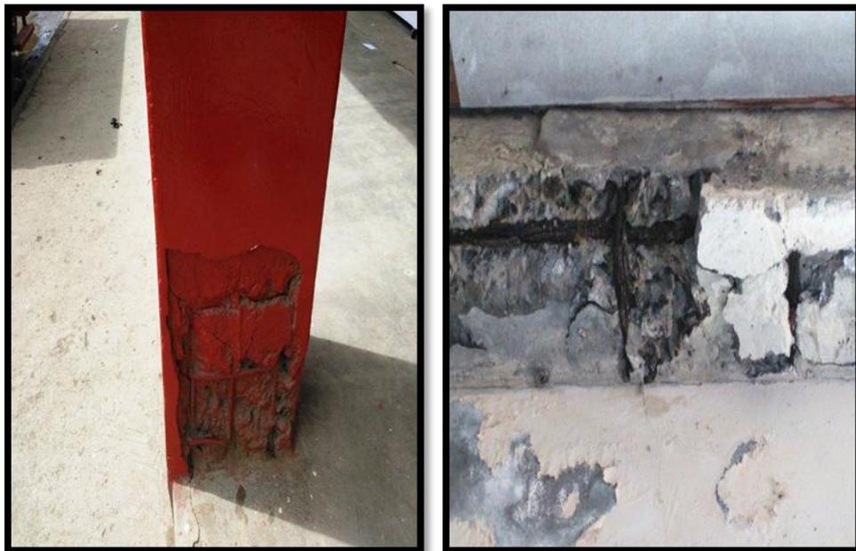
**FIG. (2) SE IDENTIFICA LA ARMADURA TANTO DE VIGA COMO DE COLUMNAS, LA DISMINUCIÓN DE LA SECCION TANTON DE HORMIGÓN COMO DE ACERO.**
