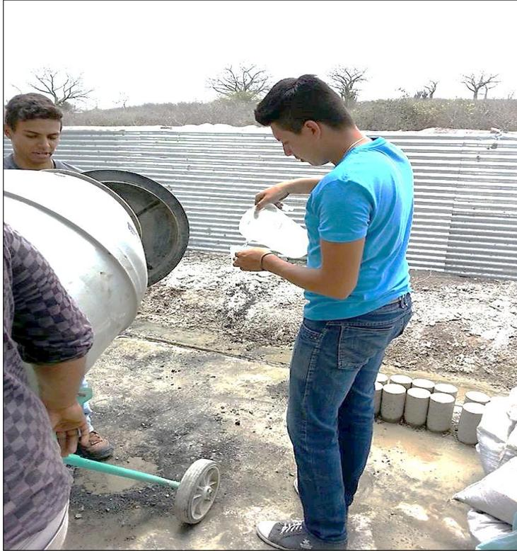
**Fotografía #15 – Aplicación de los aditivos a la mezcla de hormigón.**
