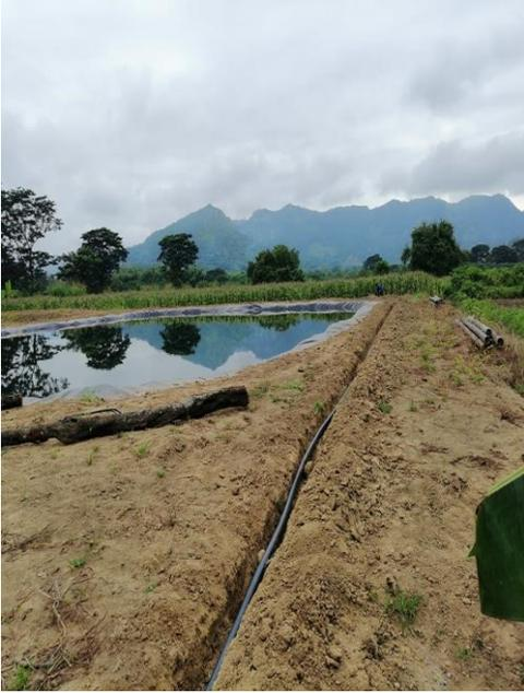
**ANEXO 9. CONSTRUCCIÓN DE ZANJAS PARA SOTERRAMIENTO DE MANGUERAS**
