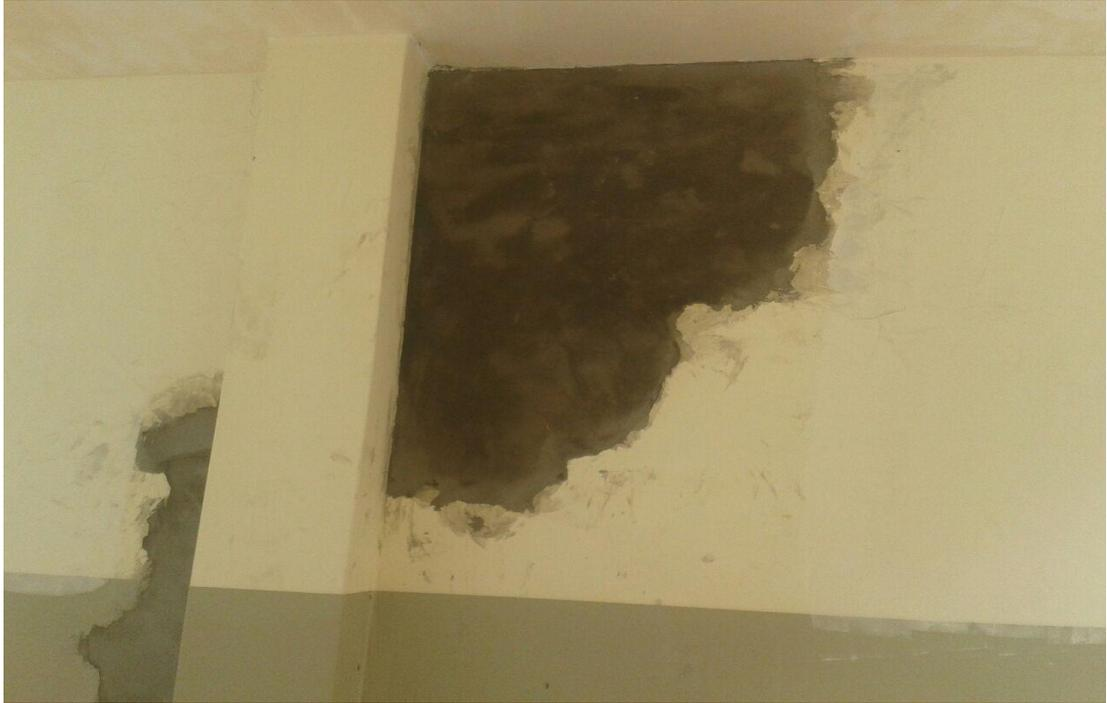
Reparaciones de las paredes fisuradas o agrietadas
