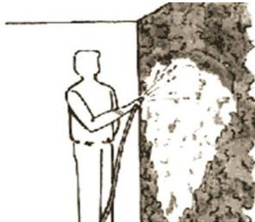
Imagen 52. Hidratación de primera capa de mortero
