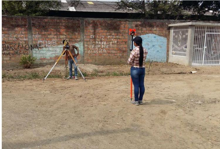
Levantamiento topográfico de la vía de acceso
