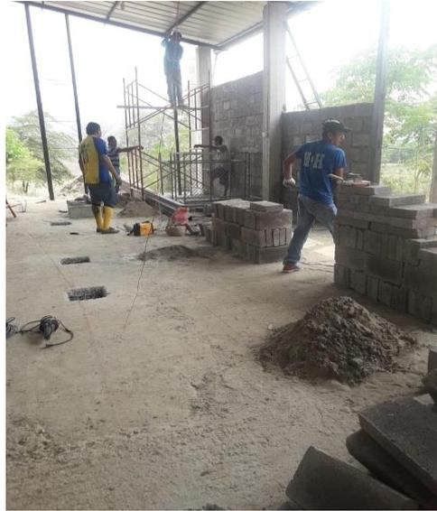
**Anexo 7: Implementación de columnas para soporte de paredes de bloque**
