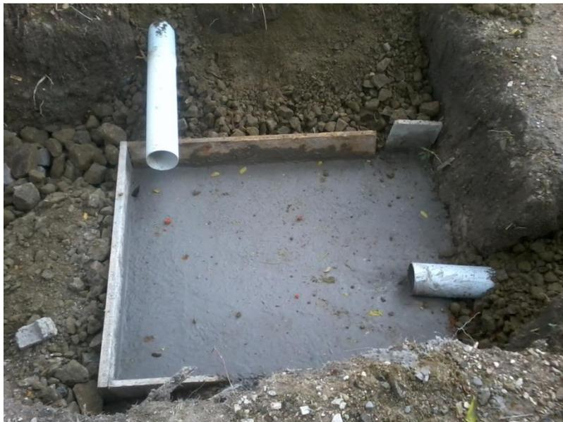
ANEXO N°11.- Tuberías de conexión entre la caja de revisión y alcantarillado publico
