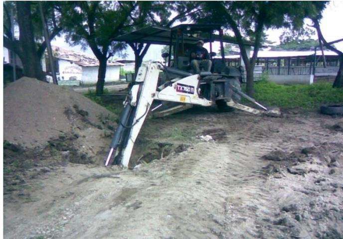
ANEXO N°4.- Se continuó con la excavación y desalojo a mano. Para luego rellenar y compactar el terreno en el área donde irá la caja de revisión.
