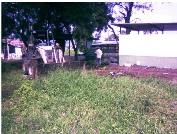
ANEXO N°3.- Se comenzó la excavación y desalojo a máquina en el área donde se comenzaran los trabajos de elaboración de los plintos y de la caja de revisión de aguas servida
