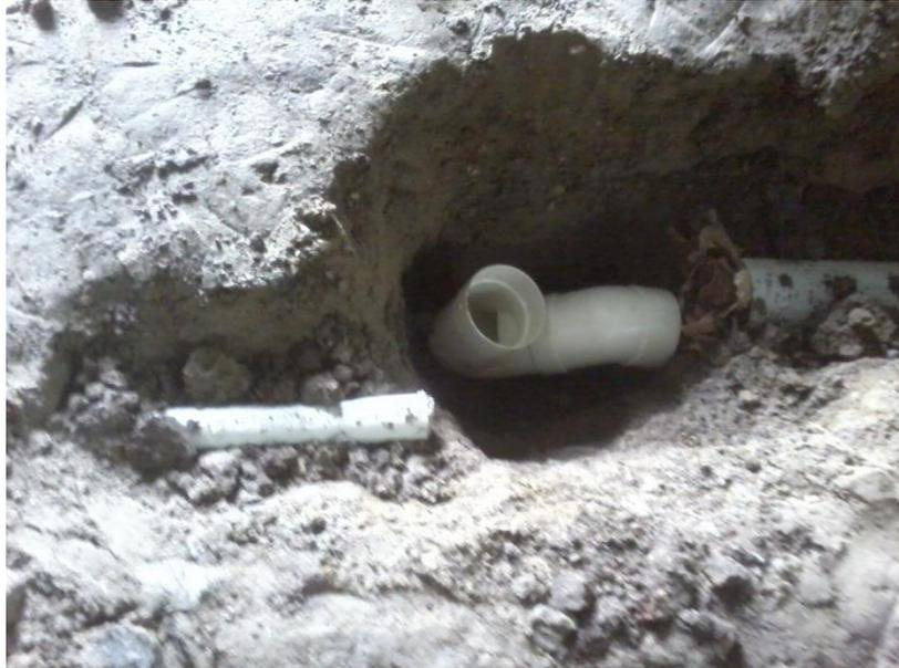
ANEXO N°6.- Se procedió a la construcción de la trampa de arena (1m x 0.80m x.0.80) colocación de tubería (110 mm) a la red principal.
