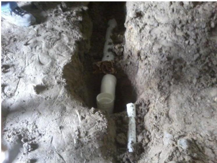
ANEXO N°9.-Tuberías de conexión entre la trampa de arena y la caja de revisión.
