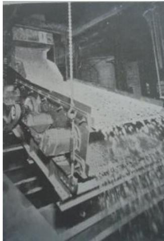
**Figura 5.** Criba vibratoria formada por dos tamices en cascada y accionada mecánicamente, en funcionamiento. (W. S. Tyler Co.)
