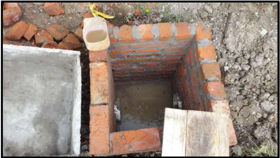
**FOTO#20: Construcción de caja de revisión**
