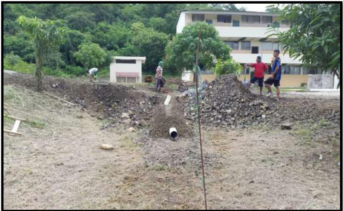
**FOTO#18: Trabajos de instalación de drenaje**
