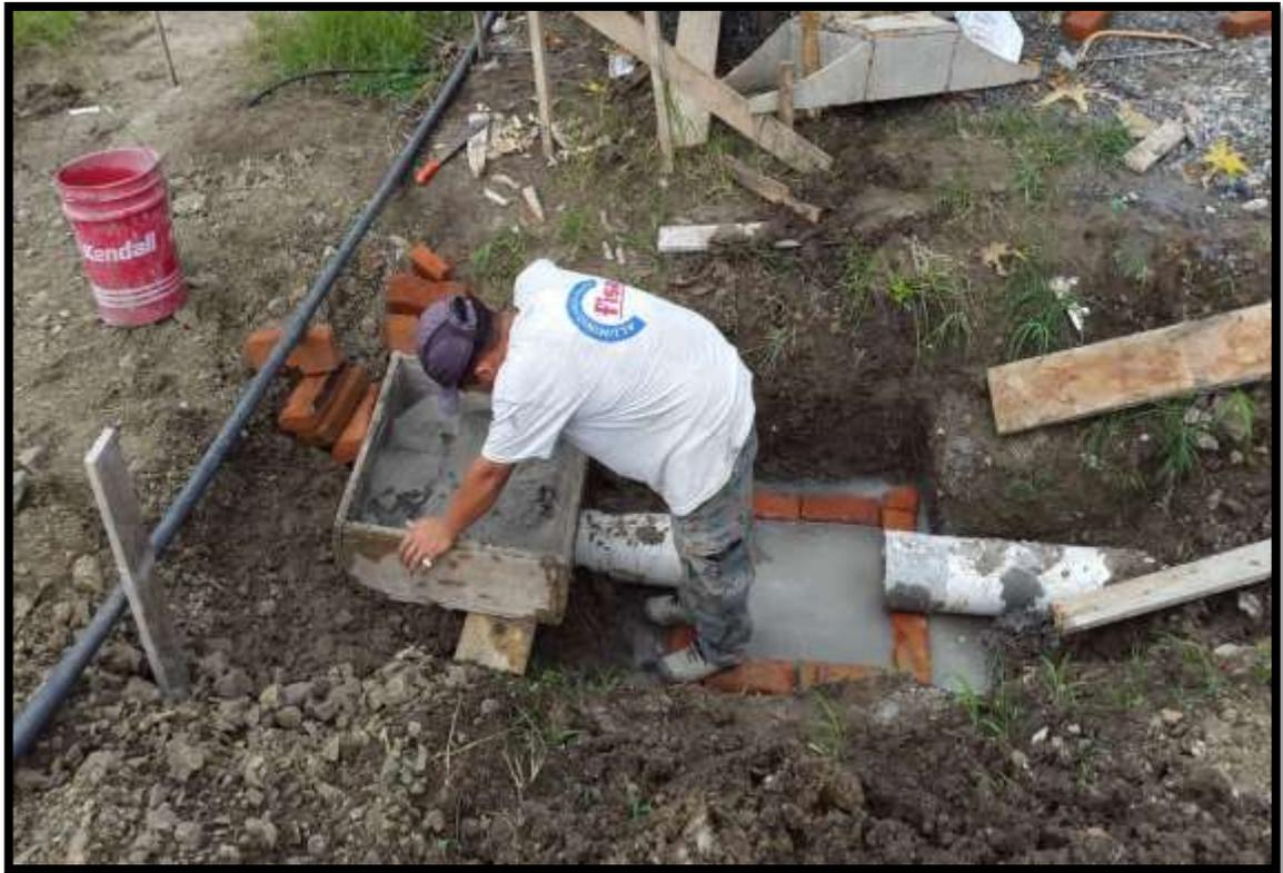
**FOTO#19: Construcción de caja de revisión**
