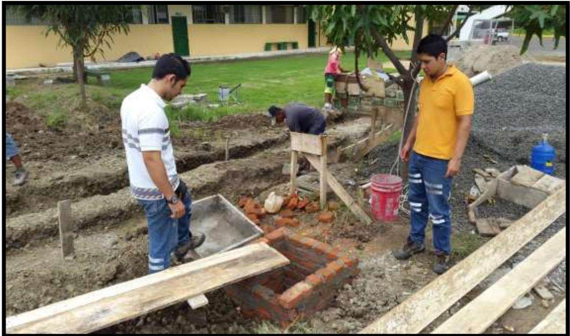
**FOTO#21: Construcción de caja de revisión**
