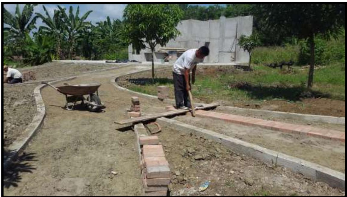
**FOTO#32: Colocación de adoquín en camineras**
