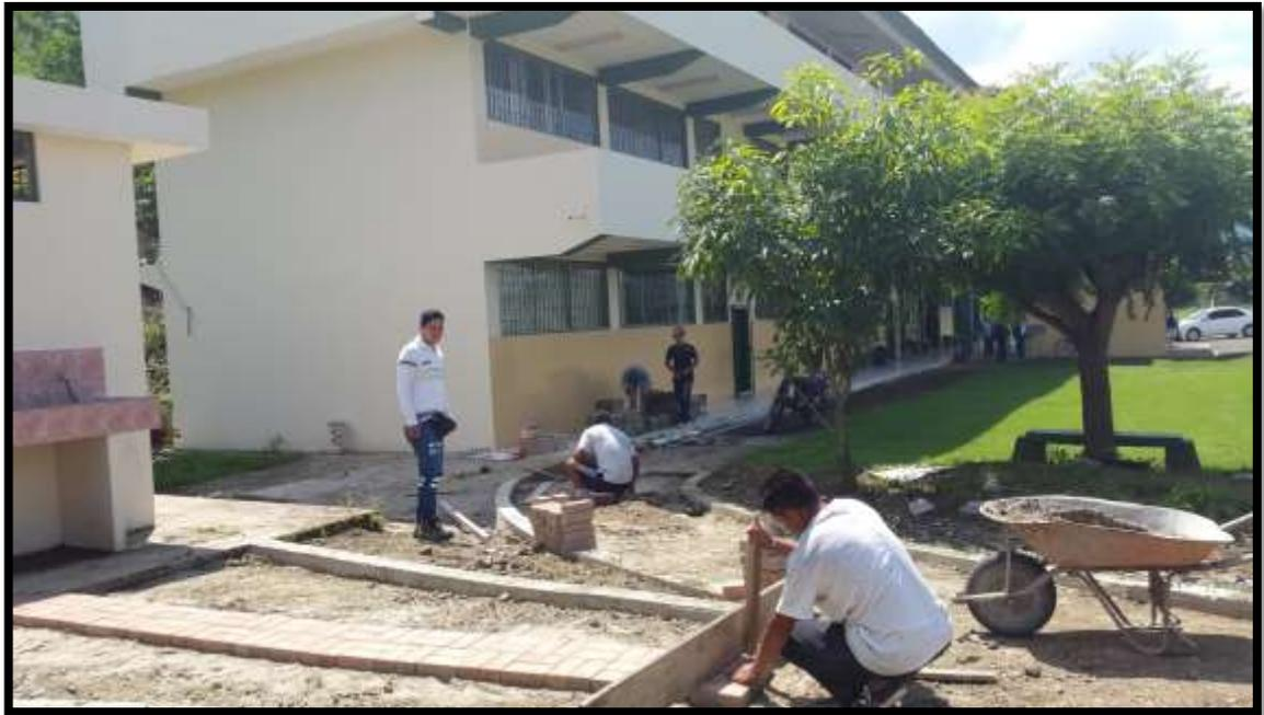
**FOTO#35: Colocación de adoquín en camineras**
