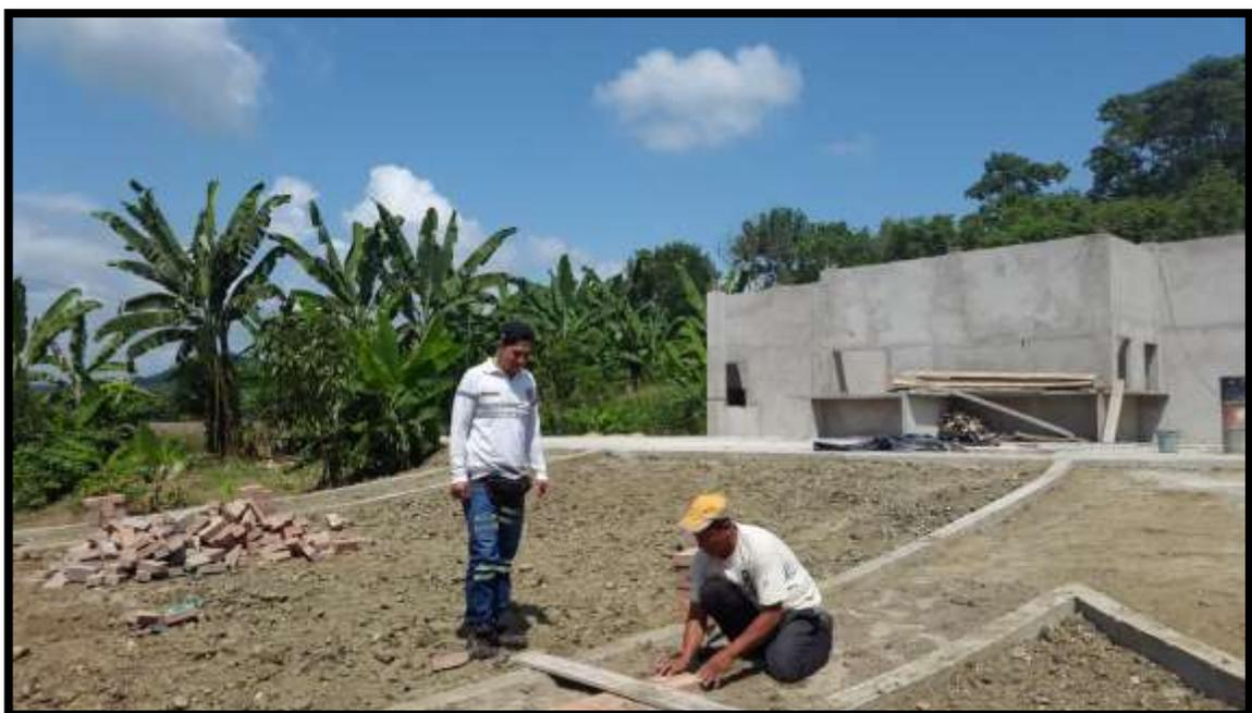
**FOTO#34: Colocación de adoquín en camineras**
