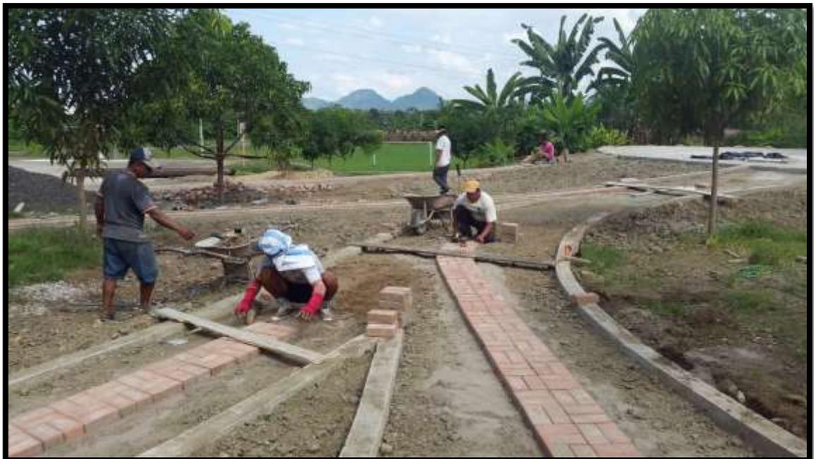
**FOTO#36: Colocación de adoquín en camineras**
