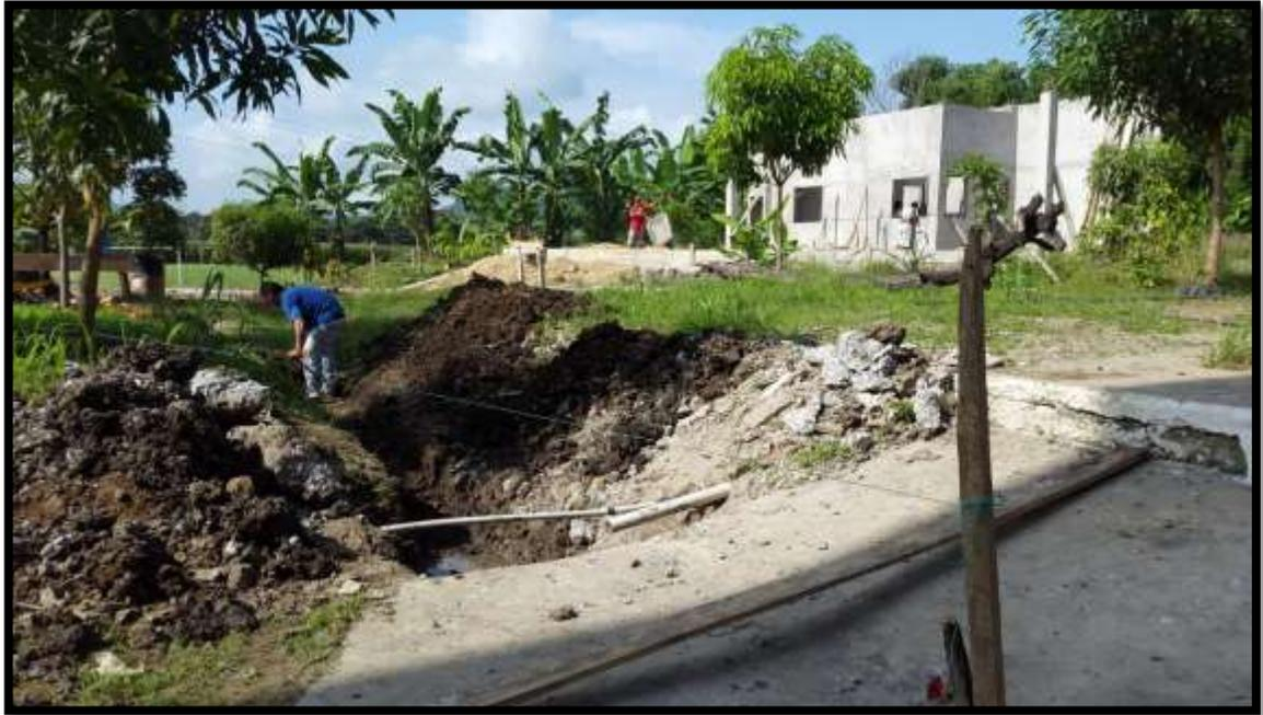
**FOTO#1: Excavación para instalación de tuberías de drenaje**
