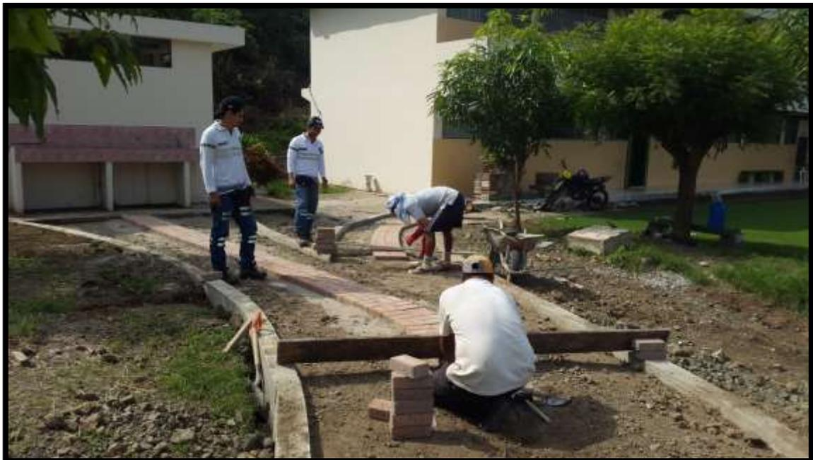
**FOTO#38: Colocación de adoquín en camineras**
