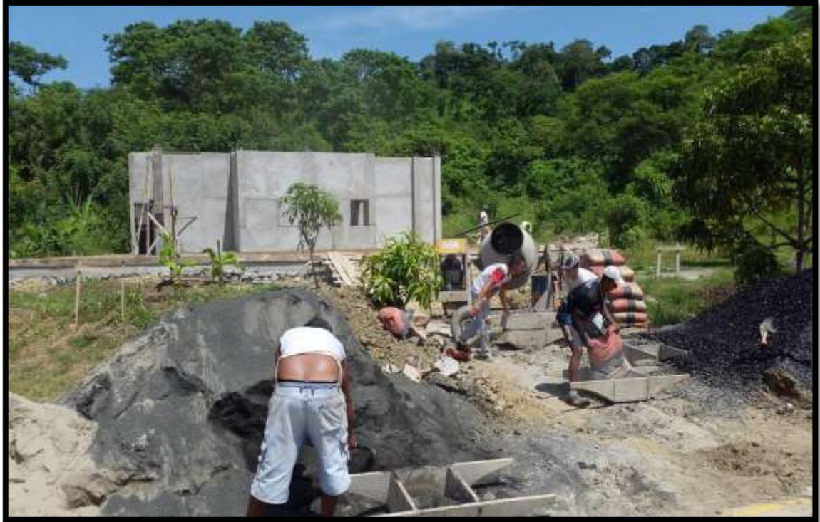
**FOTO#11: Preparación de hormigón**
