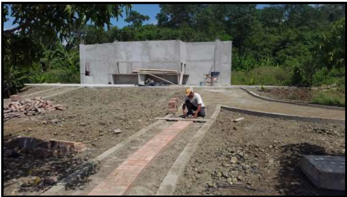
**FOTO#33: Colocación de adoquín en camineras**
