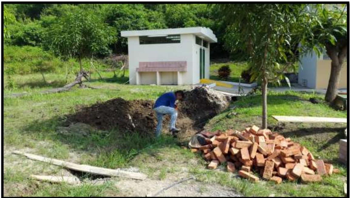
**FOTO#2: Excavación para instalación de tuberías de drenaje**
