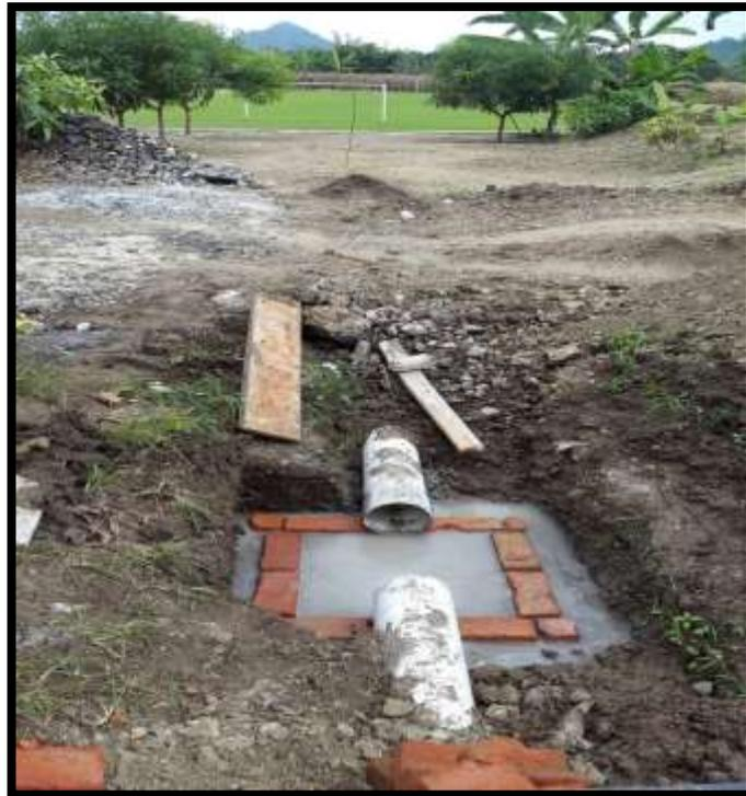
**FOTO#16: Construcción de Caja de Revisión**
