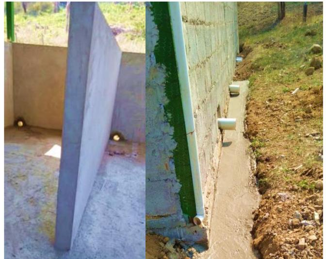
**Imagen 6.** Construcción de desagüe.
