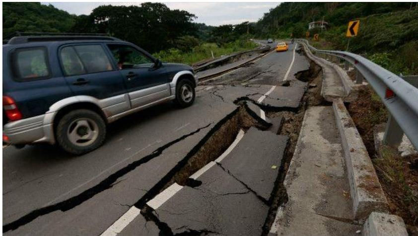
figura 5. Efectos de un terremoto en el suelo.
