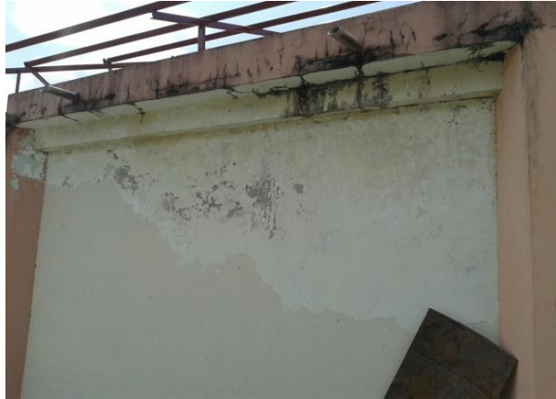
Pintura de paredes parcialmente destruida
