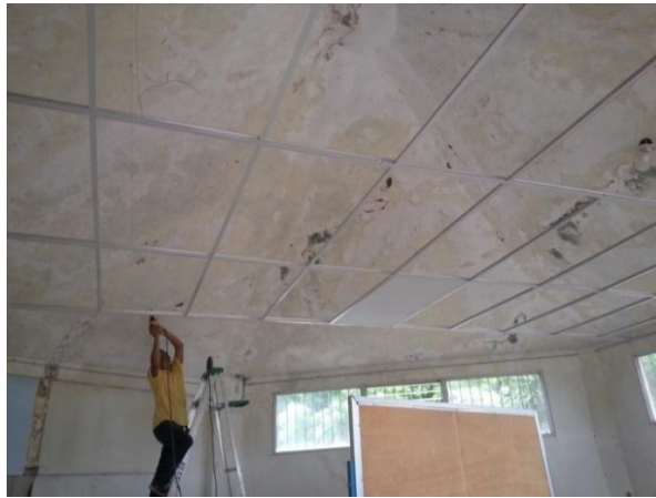
Colocación de cielo raso. (Obra paralela)
