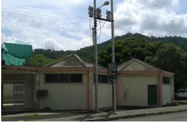
Apariencia exterior antes de readecuación
