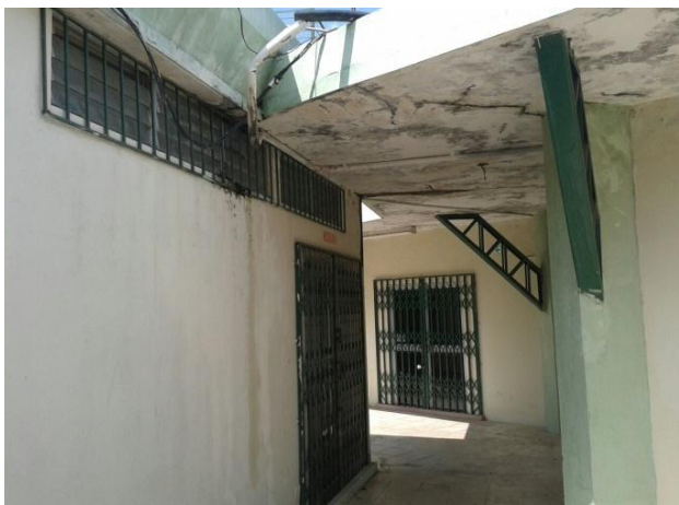
Pintura deteriorada de techos interiores
