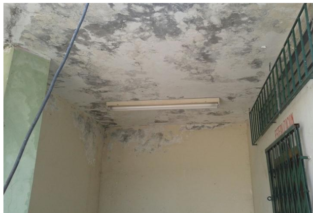
Pintura interior destruida
