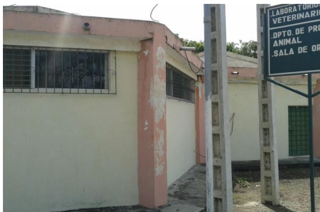
Columnas con pintura deteriorada
