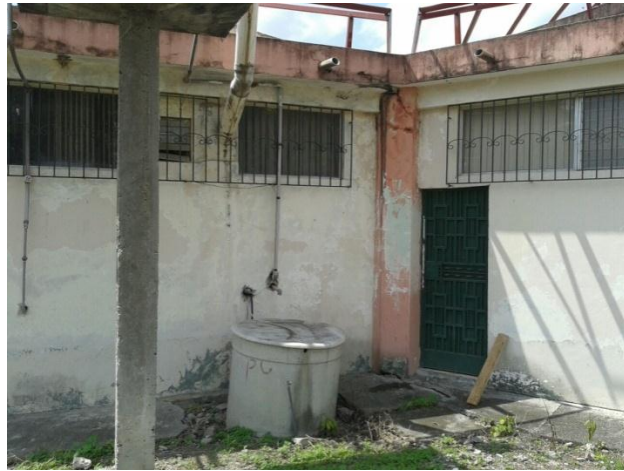
Pintura exterior previa rehabilitación
