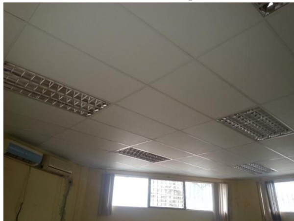
Finalización de obra paralela
