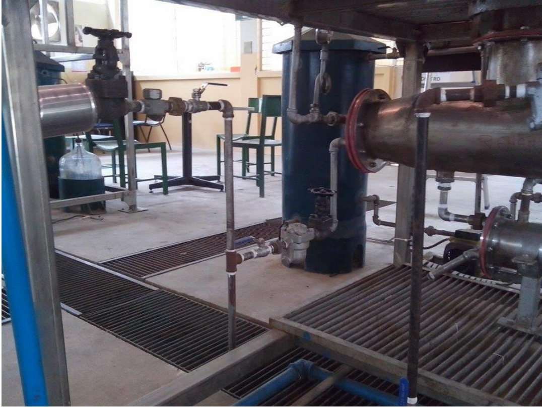
Recuperación del condensado para reenviarlo a un recipiente de almacenamiento
