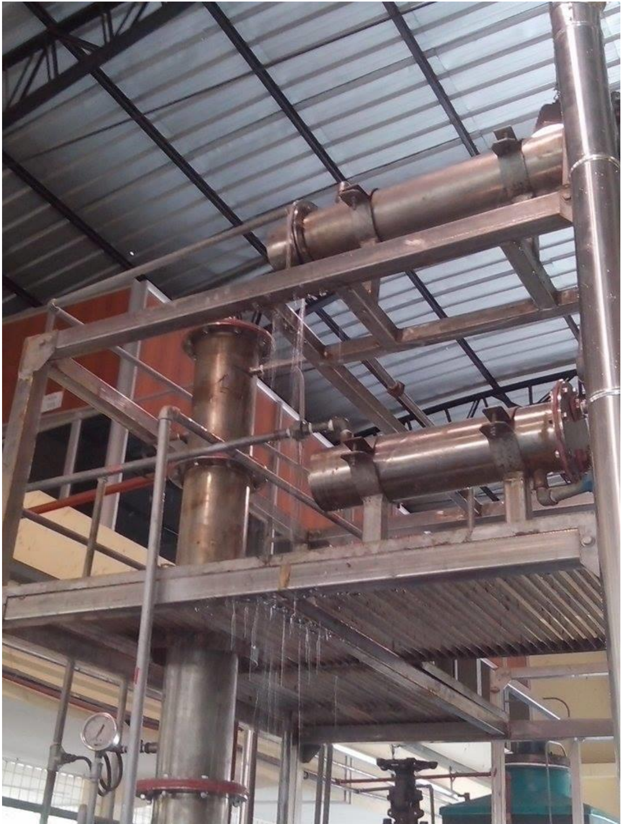
Fuga en el condensador al momento de probar la columna de destilación
