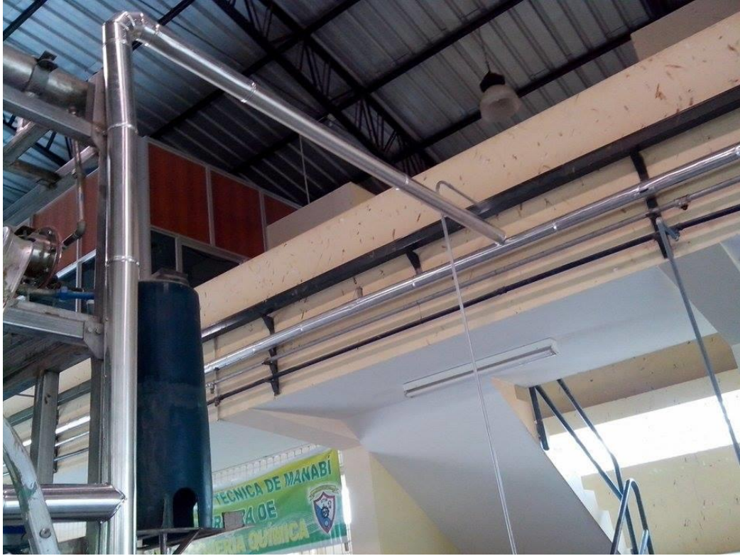
Nueva línea de entrada de vapor de agua procedente de la caldera
