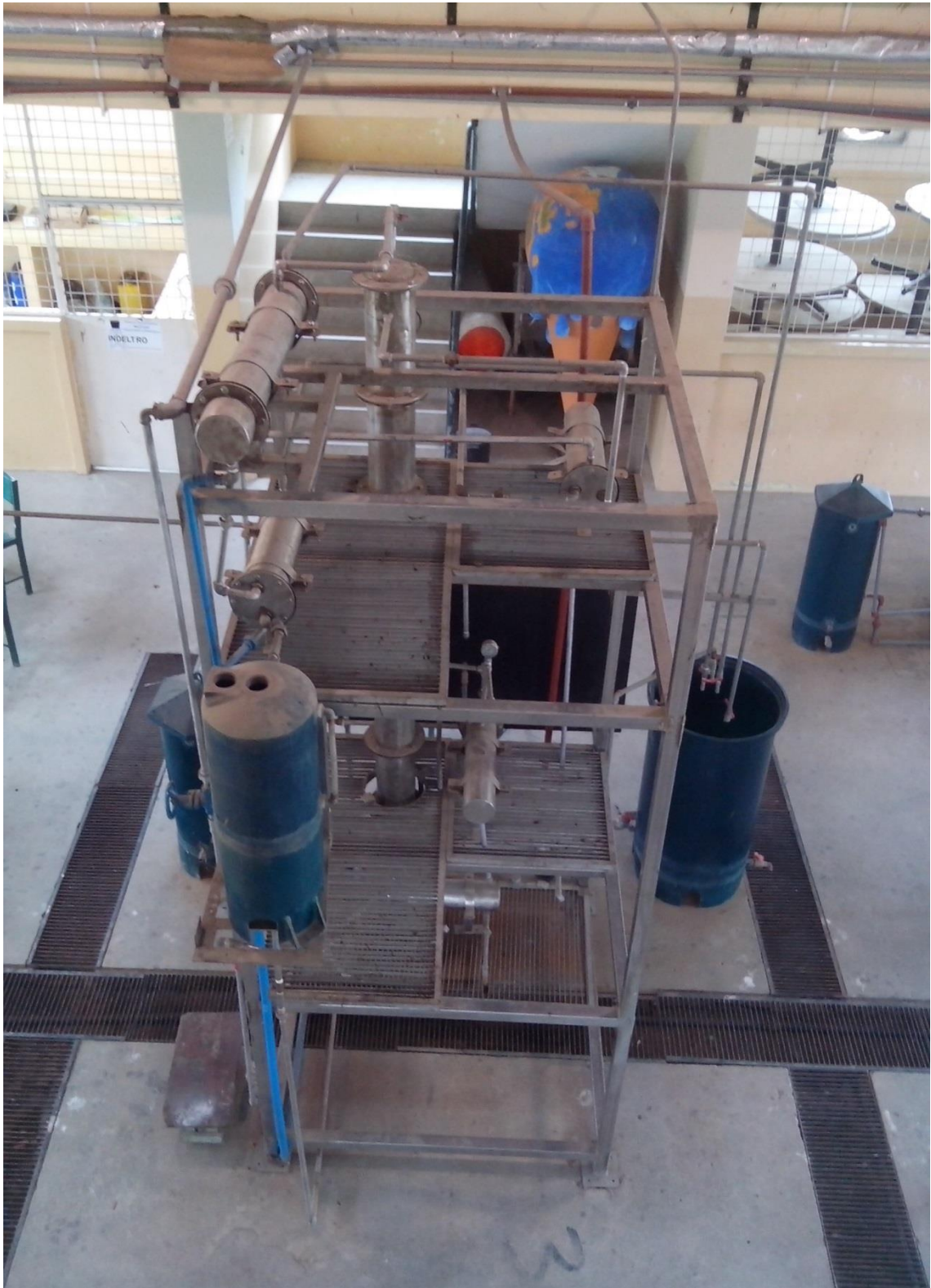
Vista Superior al Inicio del Proyecto
