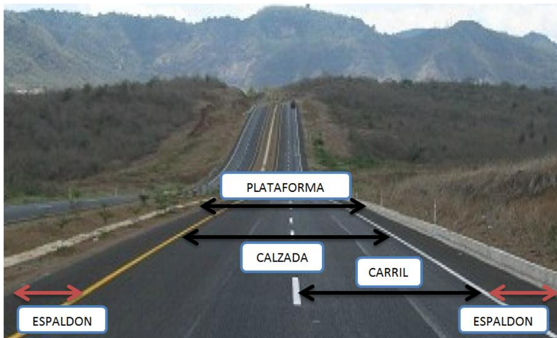
Figura 5: Detalle grafico de una vía y sus partes
