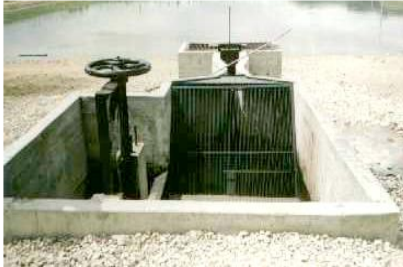
Figura #2 Esquema de una rejilla
